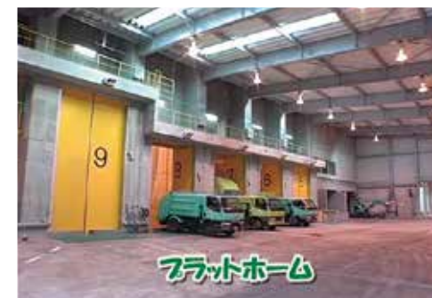
① プラットホーム
