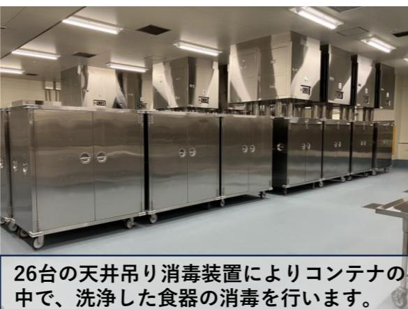
26台の天井吊り消毒装置によりコンテナの中で、洗浄した食器の消毒を行います。
