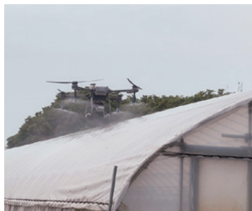
ドローンで塗布材を塗布する様子
