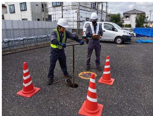
調査員が道路上の水道施設を確認します
