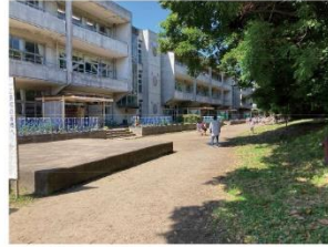
㉓南側普通教室棟
