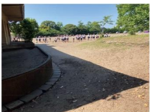
㉑給食室とグラウンドの接続部
