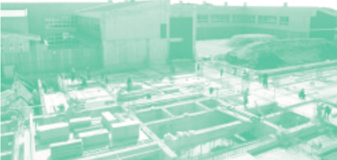
第2期工事中の富津中学校
