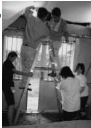
▲弁天山古墳での修復作業
