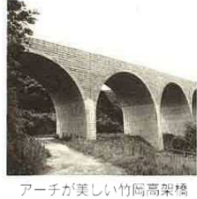
アーチが美しい竹岡高架橋
