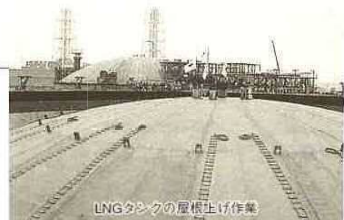
LNGタンクの屋根仕上げ作業
