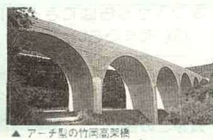
▲アーチ型の竹岡高架橋
