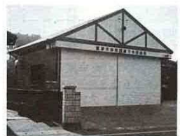
消防第12分団詰所
