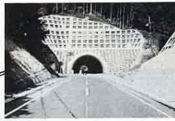
国道465号 田舎から君津方面へぬけるトンネル(九十九トンネル)
