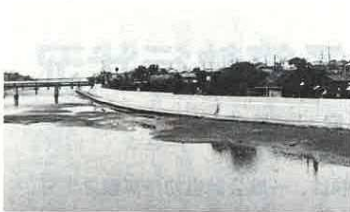
完成をめざして備々と工事がすすまれている深川親水公園
