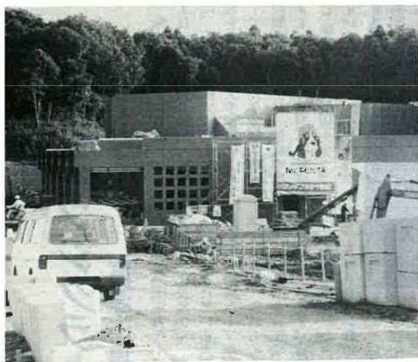
年内完成をめざして着々と工事が進む斎場
