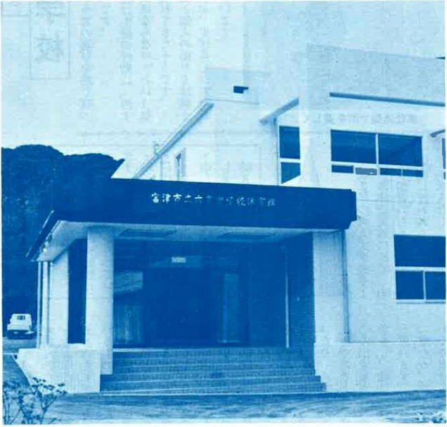
大貫中学校屋内体育館完成！
