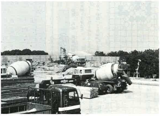
年度内完成を目指して工事が進められている県温水プール(富津公園内)
