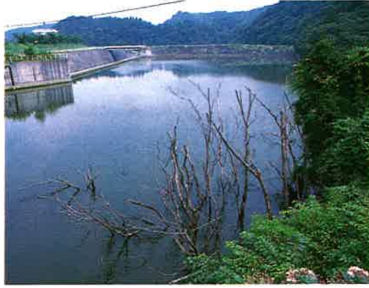
戸面原ダム完成 57年10月
