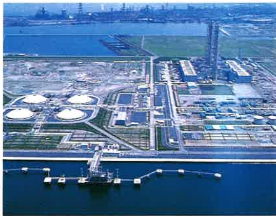
東京電力富津火力発電所一部操業 60年12月
