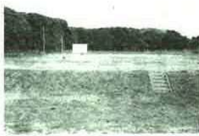
(上飯野第1配水池)
