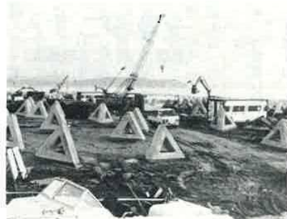
着々と整備が進められる富津漁港下州地区防波堤工事
