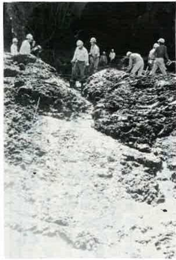
台風18号の爪あと 各地に被害をもたらした台風18号、竹岡地先にもこんな置土産を。国鉄の線路と国道に流れ込んだ土砂のため、一時は大変な交通渋滞でした。
