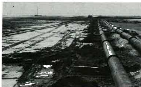
埋立地の東京電力富津火力発電所用地
