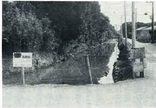
一部整備の終わった堀跡
