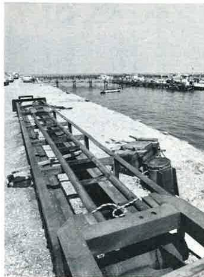
着々と工事が進む富津沖埋立
