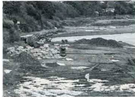
上総湊海岸沿いの工事現場
