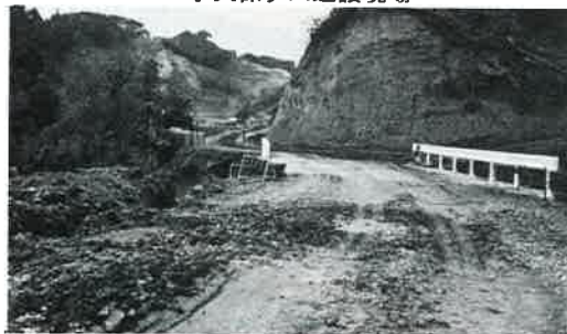
小久保ダム建設現場
