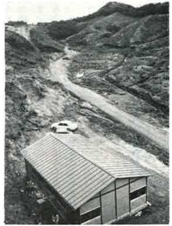
着々と工事が進む小久保ダム建設現場
