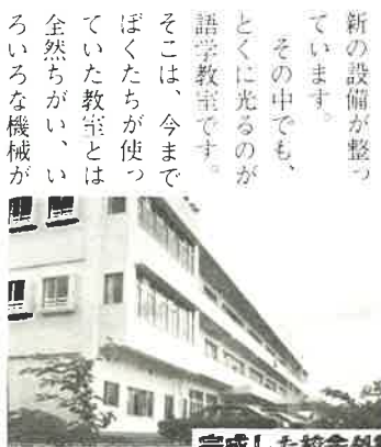
完成した校舎外観
