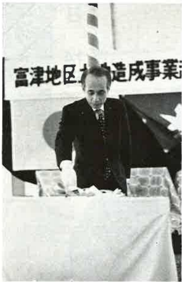
起工式でくい打ち機の始動ボタンを押す川上知事
