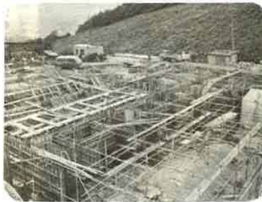
桜井不動谷に建設中のゴミ処理工場現場
