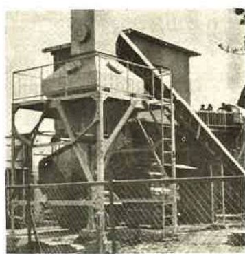
川名地先に完成したゴミ焼却場 (1日10t処理)
