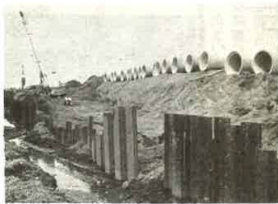
区画整備内の下水道工事
