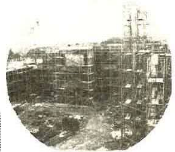
青堀小学校の建設現場
