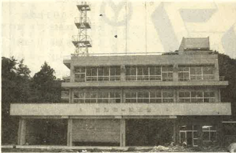
完成した消防庁舎
