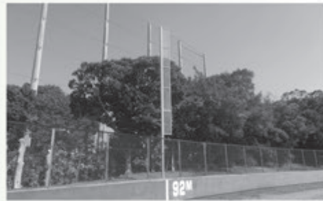
▲NIPPON STEEL 野球場の ファールポール（レフト側）
