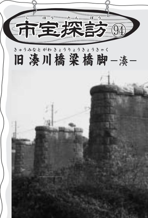
大正4年(1915)に木更津-上総湊間、同5年に上総湊-浜金谷間、同8年に安房北条(現:館山)まで、同11年に江見まで開通した国鉄北条線(現:内房線)は大正12年(1923)9月1日の関東大震災で大きな被害を受け、湊川橋梁も損壊した。木更津-上総湊間の線路の復旧は同年9月14日までに速やかに行われたが、旧陸軍鉄道連隊による橋梁の全面的架け替え工事にはその後1カ月を要した。湊川の兩岸には震災前の旧湊川橋梁の煉瓦積みの橋脚が今も残されている。
