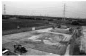
▲建設工事の様子
