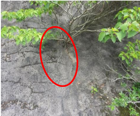
吹付モルタル (変状: 土砂突出)
