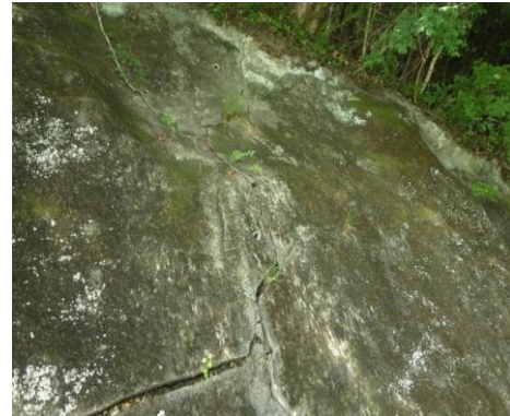
吹付モルタル (変状: U字溝破損)
