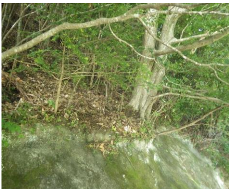
吹付モルタル (変状: 土砂突出)
