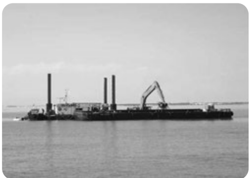
市営大貫漁港浚渫工事の様子
