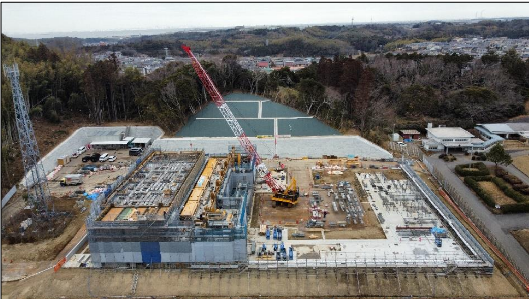
火葬棟(2階)の配筋や型枠設置 (令和4年1月)
