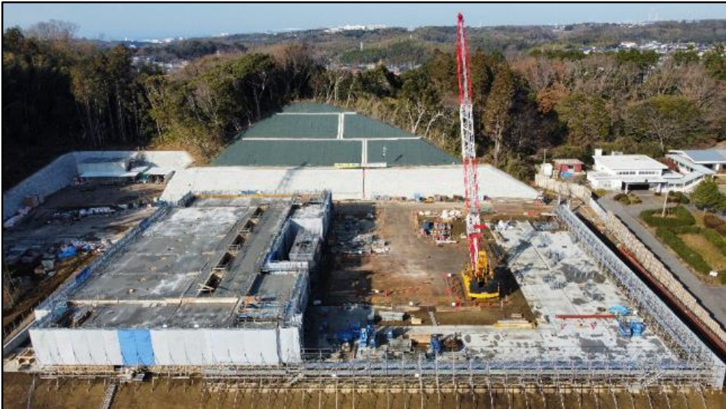
火葬棟(2階)の配筋や型枠設置 (令和4年1月)
