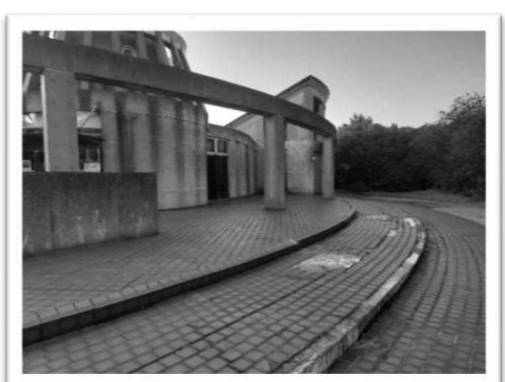
・ 入口右手前 (タイル)
