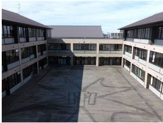
3階 渡廊下から
