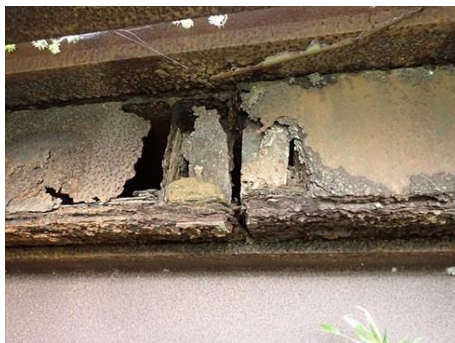
No.27 大六天橋 床版の腐食
