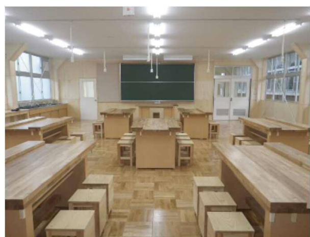
天羽中学校校舎(技術室) 耐震補強事業 (平成25年度)
