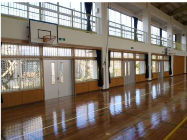
湊小学校屋内運動場 耐震補強事業 (平成25年度)
