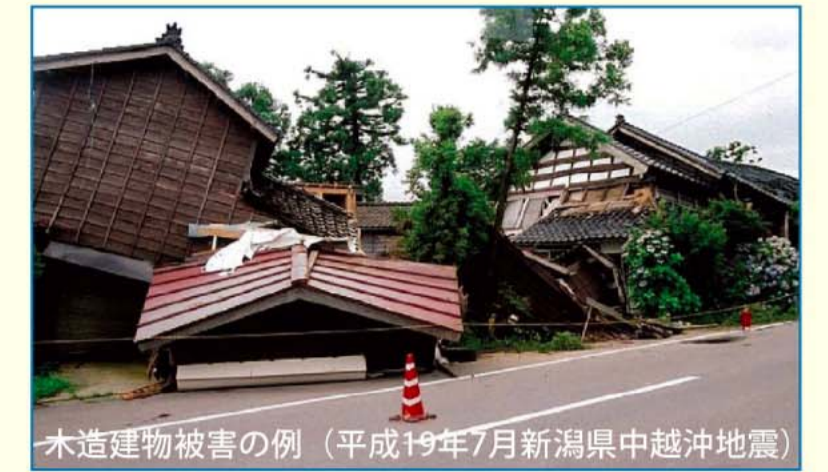
木造建物被害の例（平成19年7月新潟県中越沖地震）
