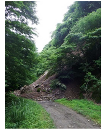
被災現場（山中地先）
