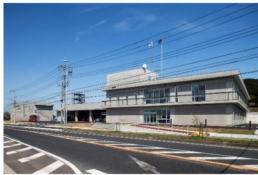
消防防災センター
