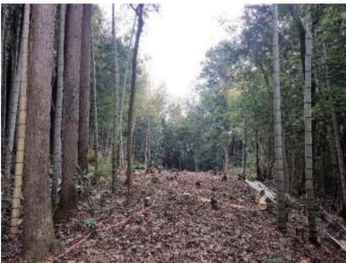
写真-1.7 新たなルート開拓のための伐採
