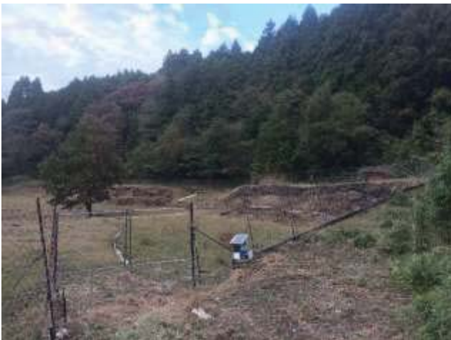
写真-1.4 改修前の T14
