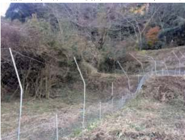
写真-1.1 シカやイノシシ等により損傷した電気柵 （富津市宇藤原地区 U4。碍子の脱落、ネットの破れ、柱の折れ曲がり等あり。）
