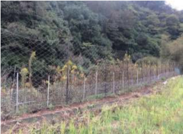
写真-1.2 改修前の T10+T15
